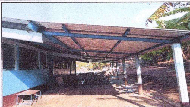
Foto 2: vista Frontal del establecimiento, cambios de costaneras y laminas troqueladas del corredor
