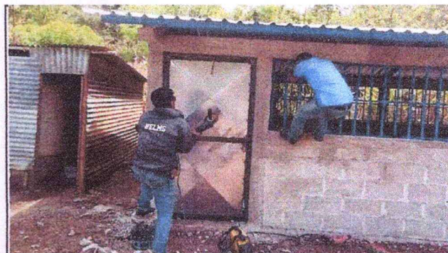
Foto 4: Instalacion de puerta de metal de la cocina del centro estudiantil
